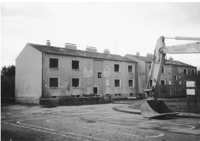
Die Notunterkunft Alstadener Straße kurz vor dem Abriss
