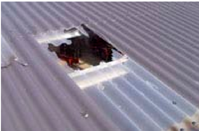
Die Tragfähigkeit von Dächern wird oft überschätzt
