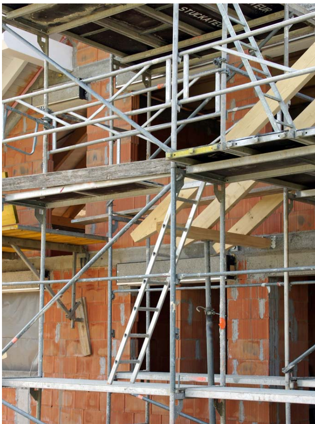
Sicherung der Arbeitenden durch ein Gerüst (© s.media/PIXELIO)
