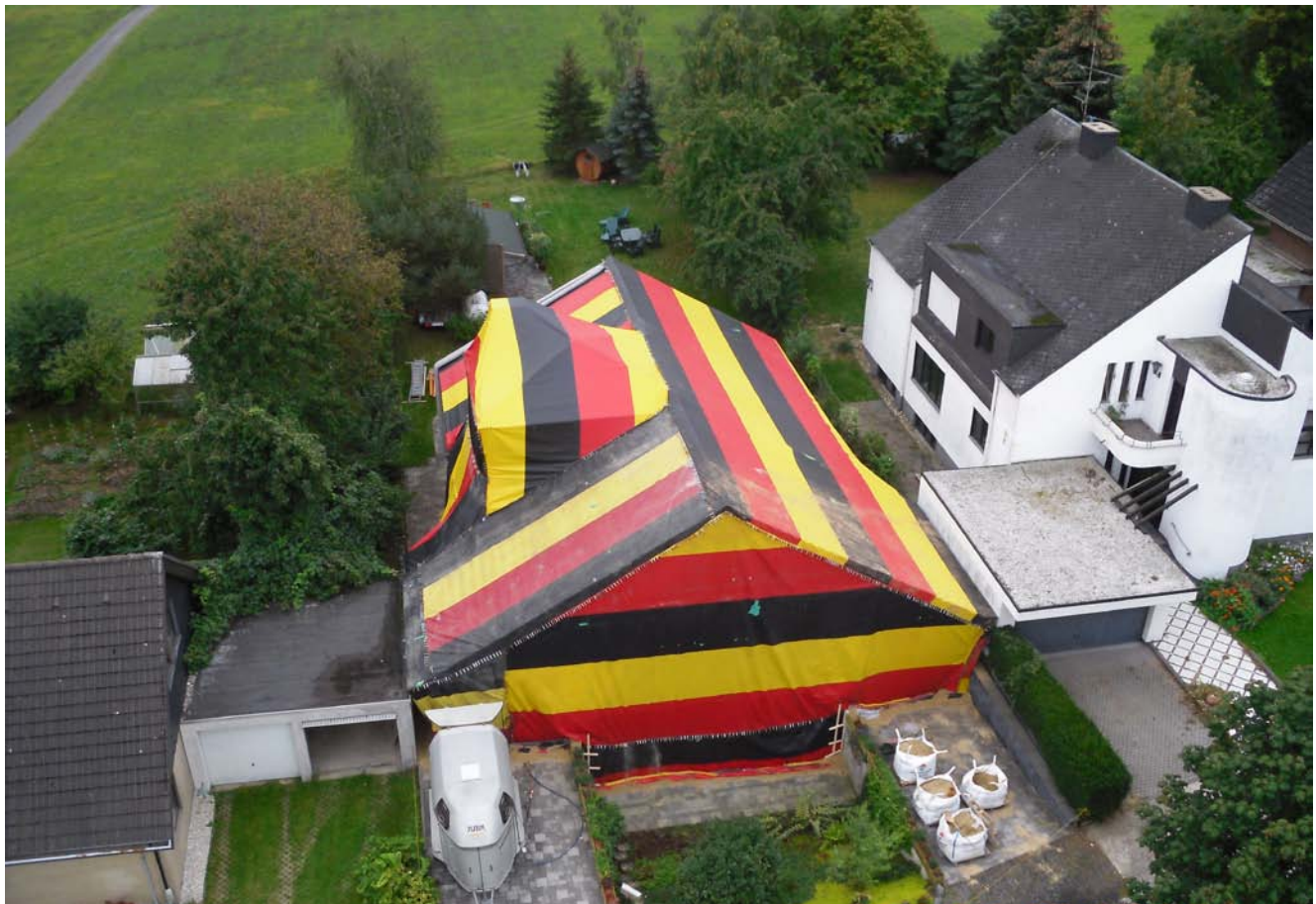
Planeneinhausung eines zweigeschossigen Blockhauses
