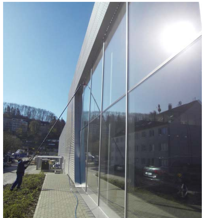
Das neue Stangensystem im Einsatz
